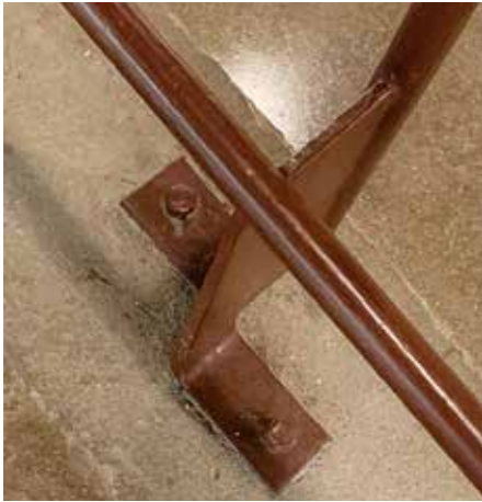
Paulo Mendes da Rocha, Guarda-corpo do MuBE (detalhe da fixação no piso), 1986. Aço
